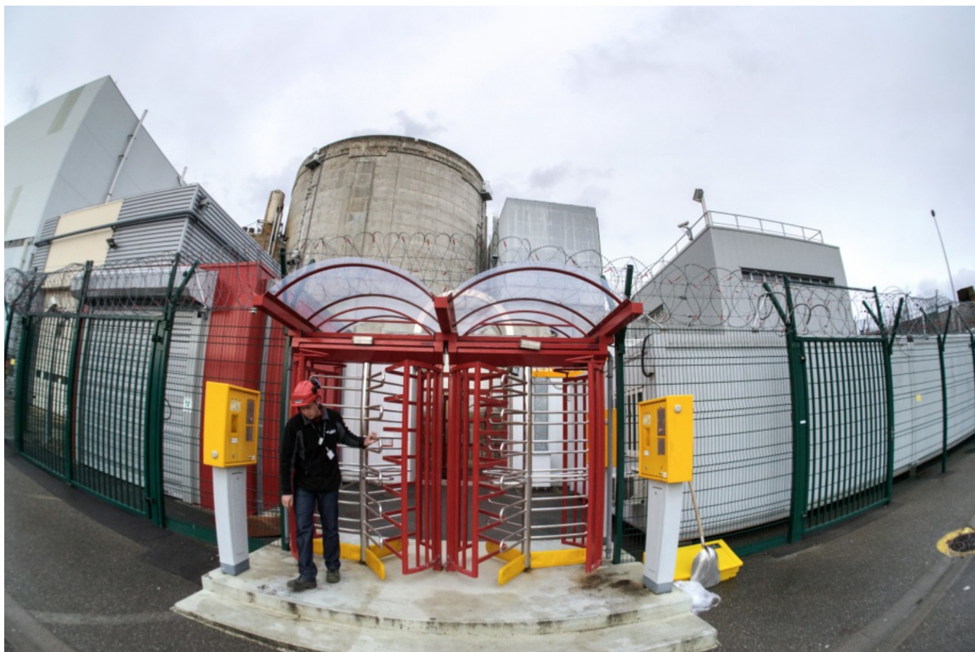
Ein Angestellter verlässt die Sicherheitszone des Atomkraftwerks in Fessenheim. Foto: afp
