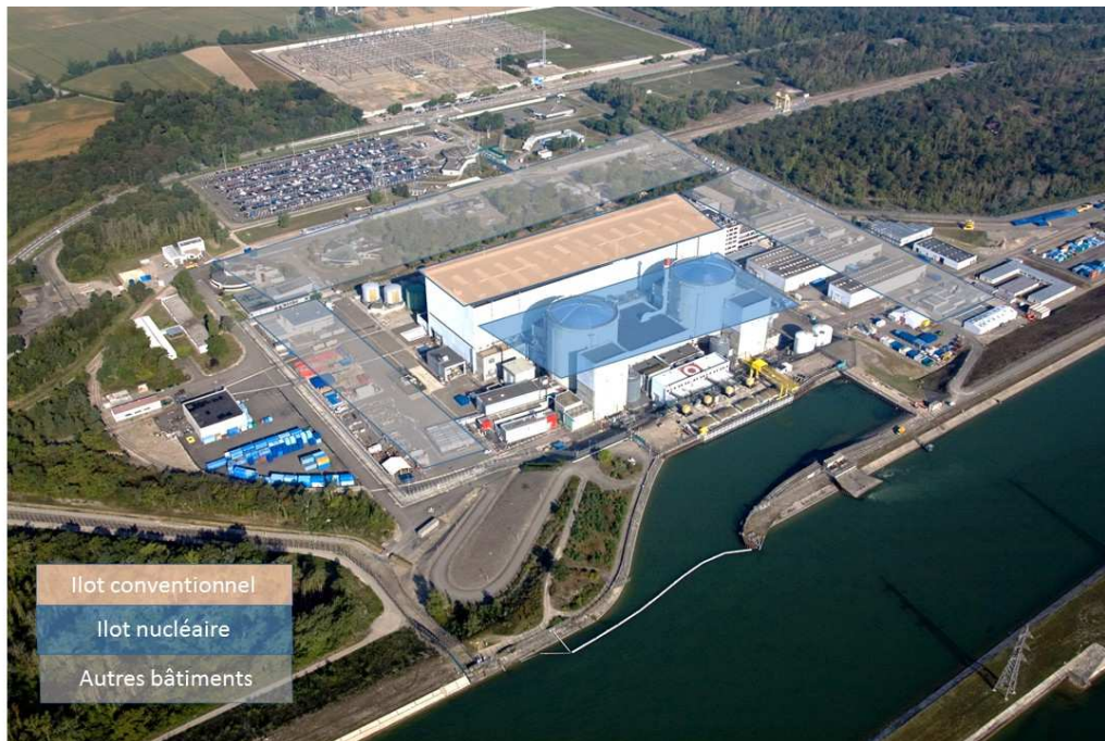
Figure c Vue des îlots conventionnel et nucléaire de l'INB n°75
