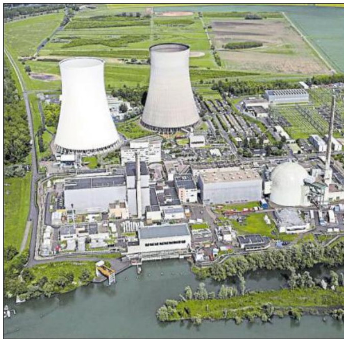
FÜR DIE TAUSENDEN TONNEN „freigemessenen“ Abfälle aus Philippsburg muss ein Zwischenlager her. Foto: Sandbiller
