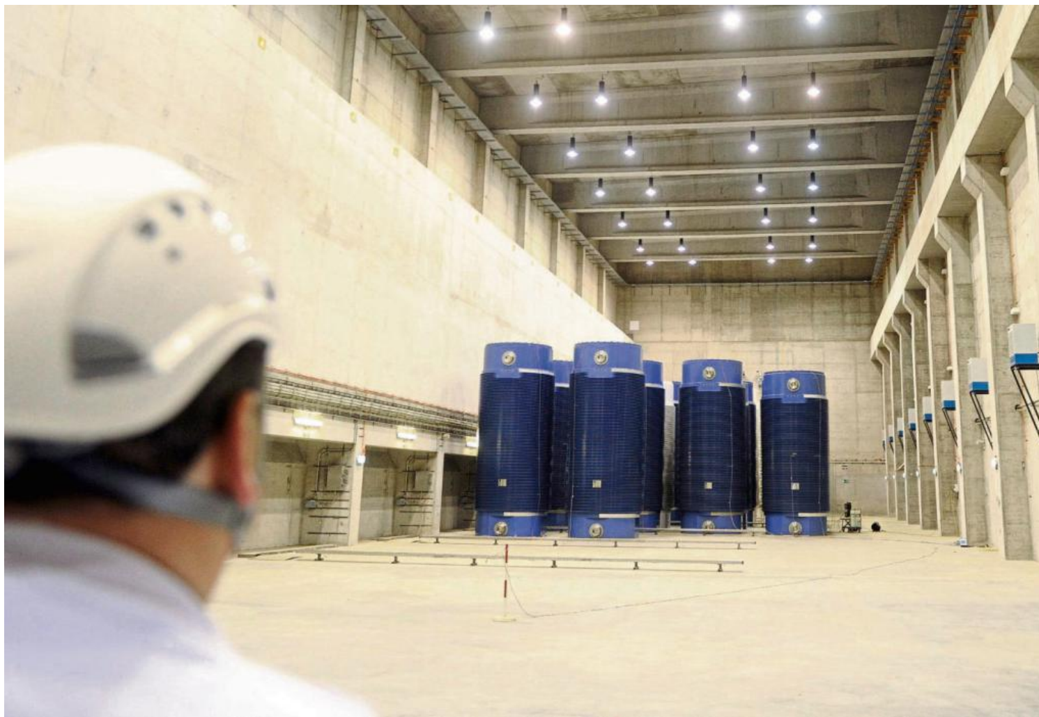
DAS ZWISCHENLAGER für Castor-Behälter im Atomkraftwerk Philippsburg ist bis 2047 genehmigt. Offen ist, wie es weiter geht, wenn bis dahin kein Endlager zur Verfügung steht. Foto: BNN-Archiv
